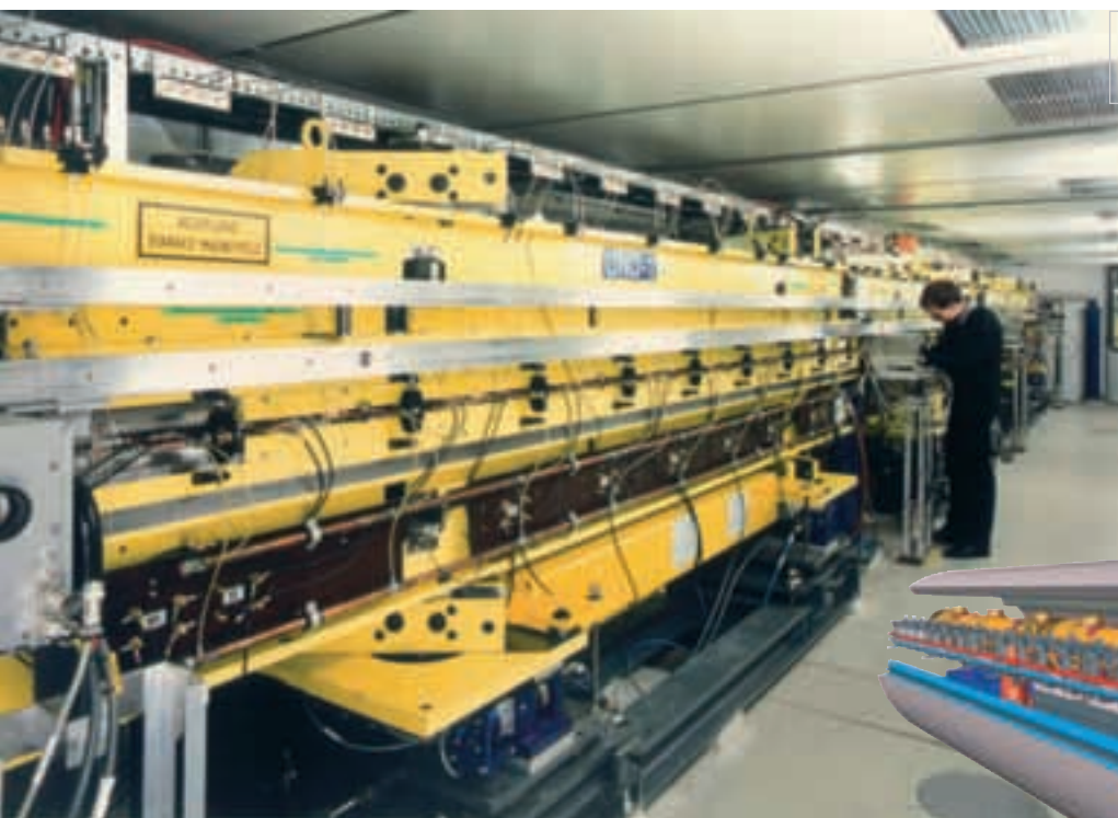
Το λέιζερ ελευθέρων ηλεκτρονίων υπό κατασκευή.
